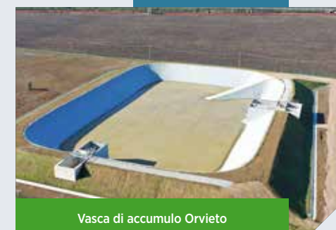
Vasca di accumulo Orvieto
