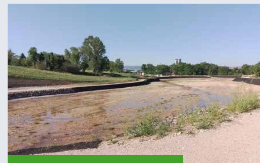
Lavori vasca di laminazione Borgo Rivo
