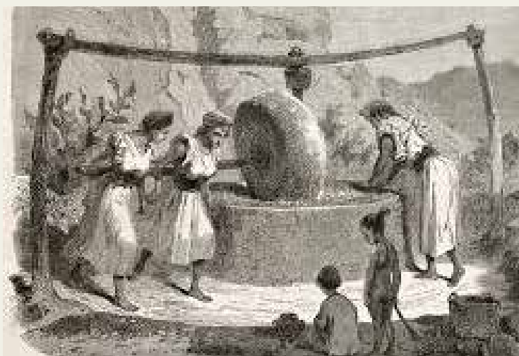
Molino ad olio nel Medioevo. Le olive venivano solitamente frante utilizzando grandi mole di pietra spinte da animali o a mano.
